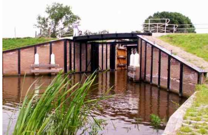
Afb. 6 De Wetsingerzijl na de restauratie, in 2013. Foto auteur
