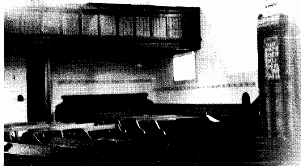
Het noordelijke gedeelte van de kerk.
