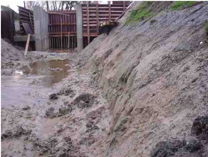
Afb 1 De bouwput van het gemaal Tilburg te Wetsinge
