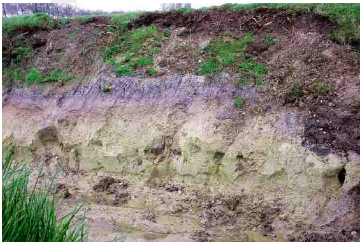
Afb. 2 De bouwput in de Wetsingermaar aan de oostzijde van de provinciale weg nabij Tilburg.
