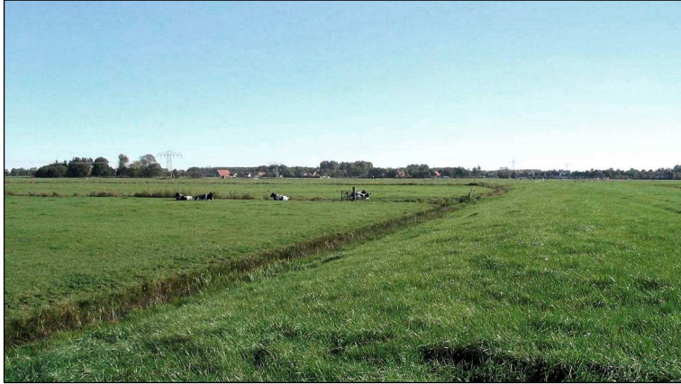
De Geuzenweg loopt over de dijk die ten noorden van het Nieuwe Gat is gelegd.
