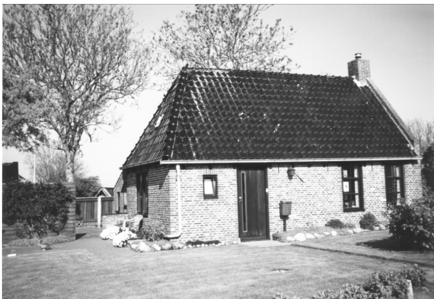
Schuttersweg2, Sauwerd: tot 1812 de woning van roode roede Rijkel Jans Holtman
