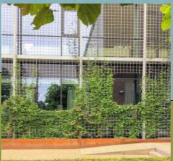
- groene gevel - Voorzijde Volle Vaart bekleed met wapeningsnetten met diverse openingen en klimplanten
