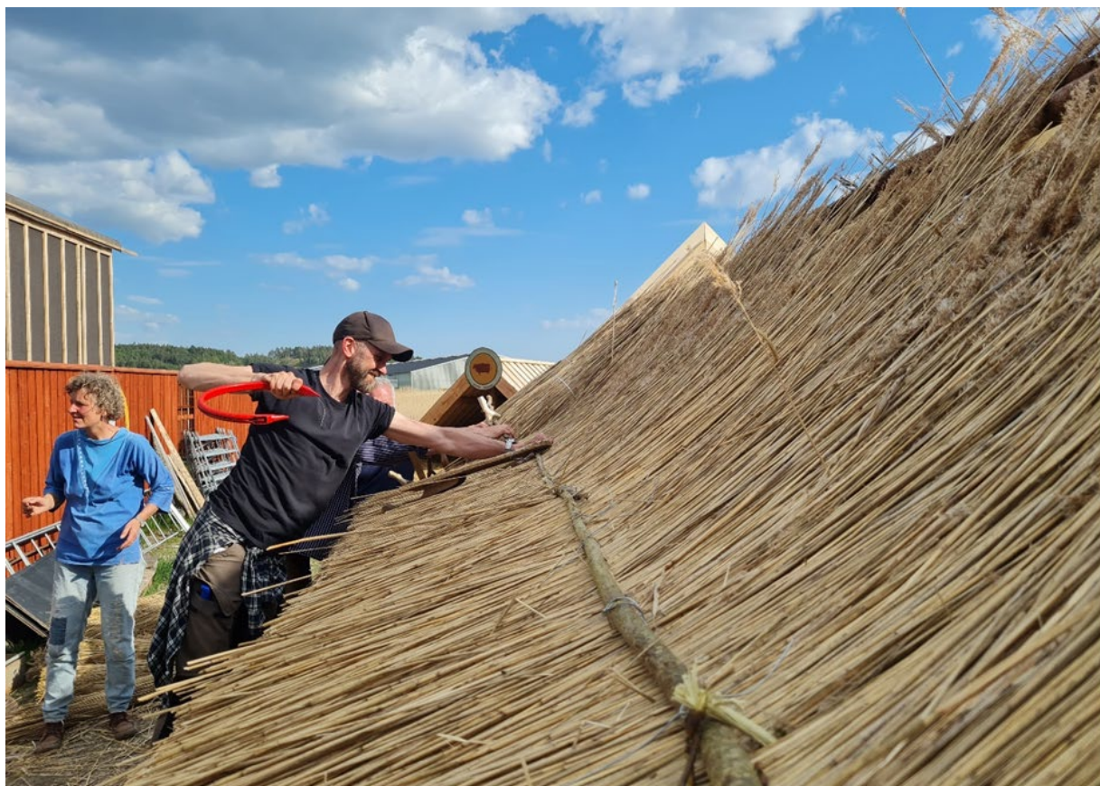
Kursen i hur man lägger vasstak, ett hållbart hantverk som hölls av den rutinerade Joar Nilsson.
