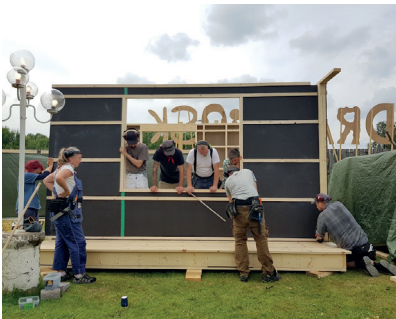
RESNING AV VÄGGAR, INPLACERING LOFT-BJÄLKLÄG.
