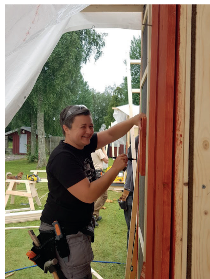
SPIKNING AV FASADPANEL UNDER PRESSNING.
