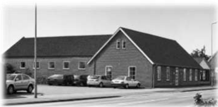
Forsamlingshuset i Ørum er nu nedrevet og der er opført boliger på grunden – Østergade 6
