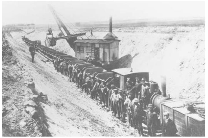
Udgravning til jernbanen
