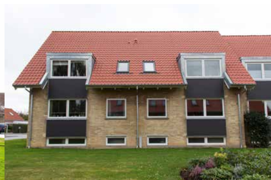
EFTER: Efter udskiftning af tage og vinduer samt efterisolering af tagkonstruktioner, loftrum og facadepartier under kvistvinduerne i Rønnehaven.
