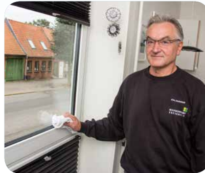
"Kondens [vand] i vindueskarmen er et typpisk tegn på, at der er for meget fugt i en bolig", fortæller varmemester Alex Hofstedt.
