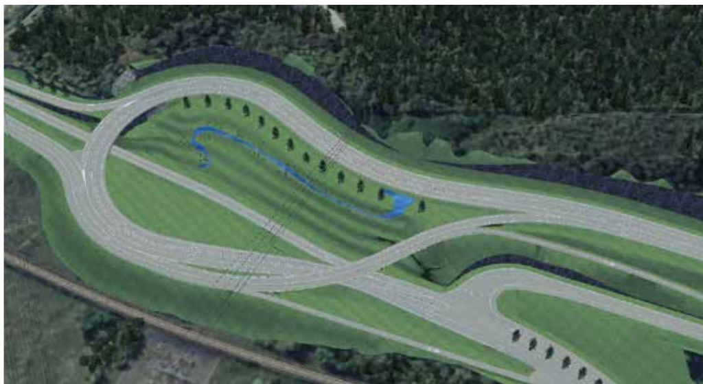
Korsningen mellan E14 och Timmervägen byggs om och blir planskild.
