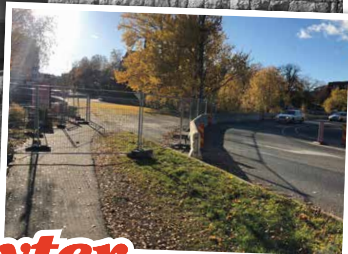
Nu: Betongbron har stängts av för all trafik i väntan på rivning och trafiken leds om via Badhusparken och en tillfällig bro uppströms.
