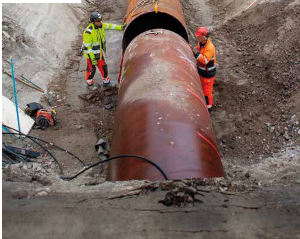
Den spiralformade skruvborren roteras inne i stålroret.
