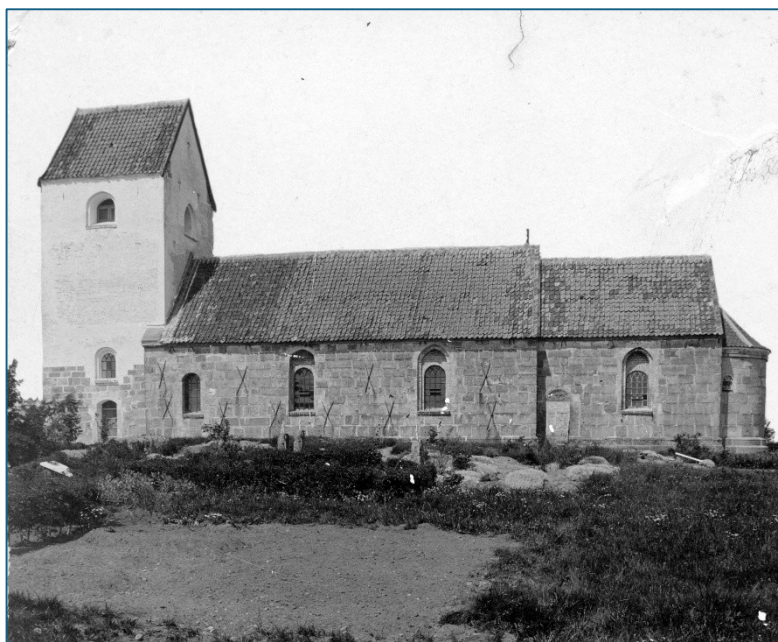
Veggerby Kirke omkring 1910
