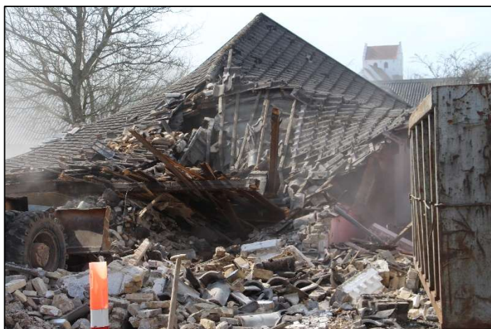
Store maskiner rev bygningen ned i løbet af en dag
