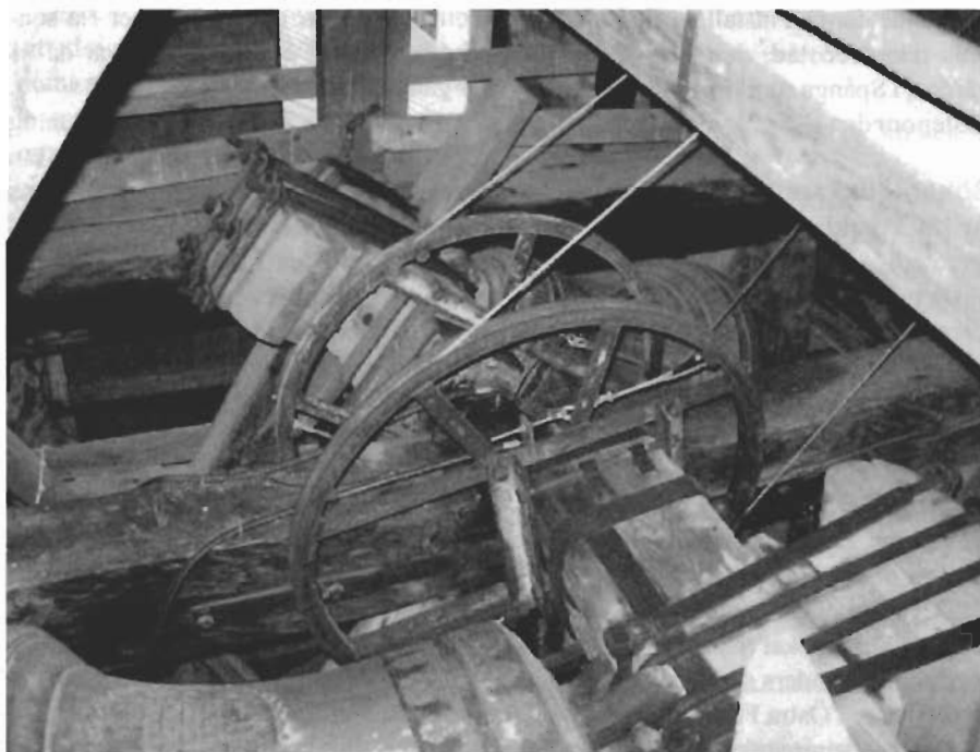
Sedan 1951 sköts klockorna i Väse kyrka elektriskt. Eftersom klockorna inte är lika stora och den maskinella drivningen gör att svängningen är konstant ringer de inte i takt som de gjorde på den tiden då klockarna i Väse skötte ringningen manuellt. Foto Sigvard Boström.
