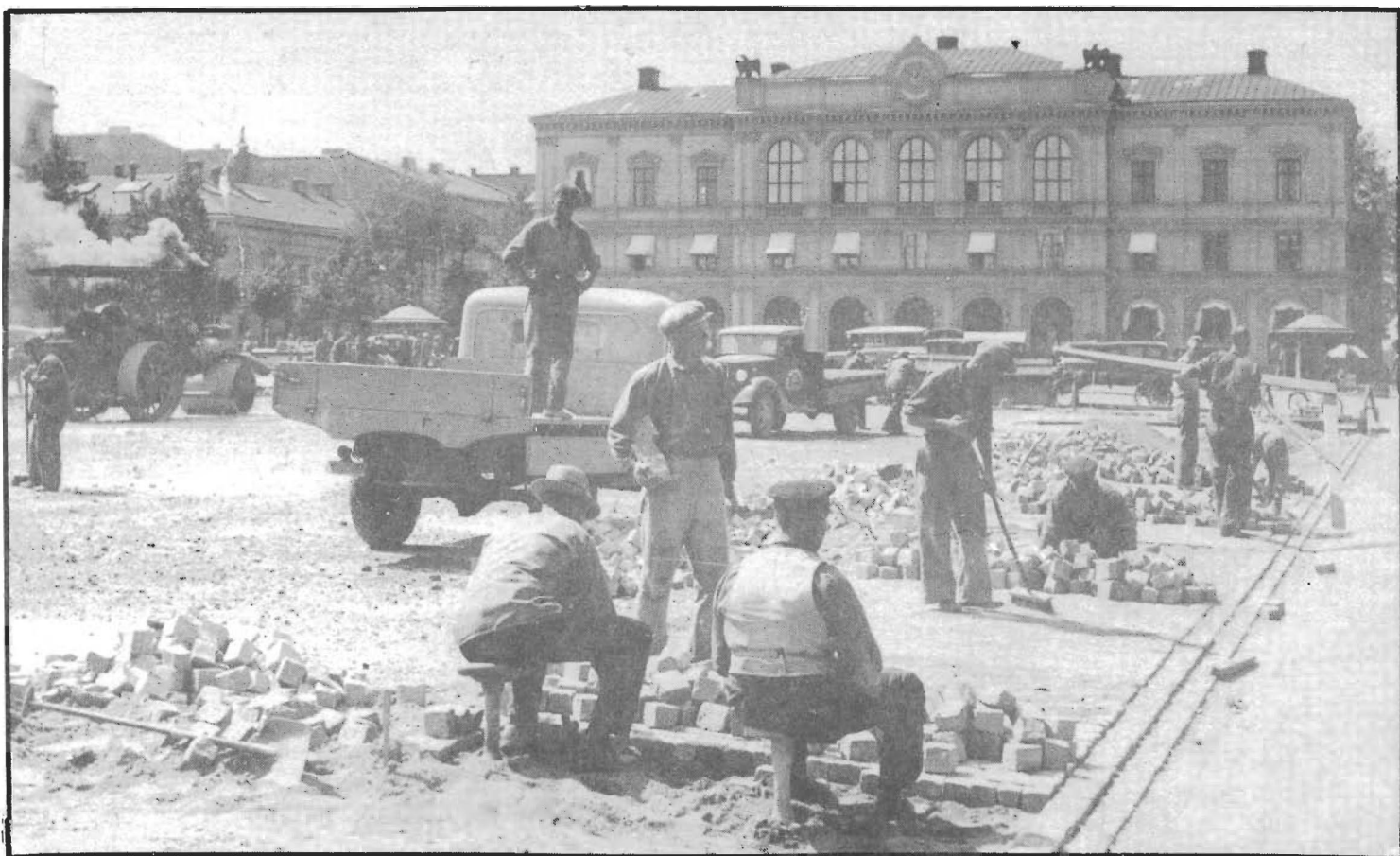
Sommaren 1936 fick Karlstads Stora torg ny stensättning, nu med tuktad sten. Icke minst den kvinnliga torgpubliken hälsade detta med tillfredsställelse. Från Carlstads-Gillet's bildarkiv.
