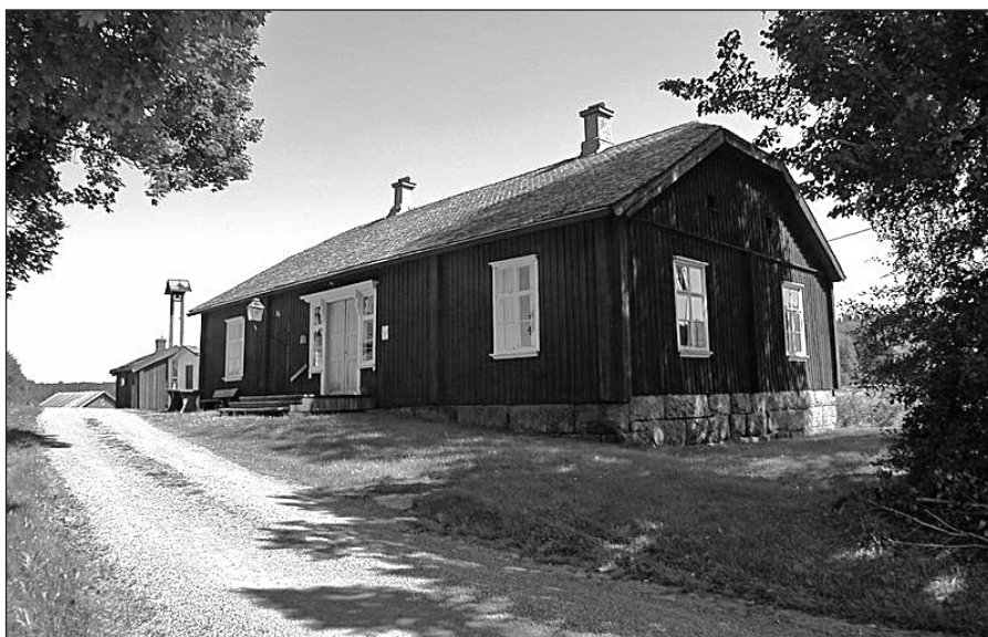
Långelanda tingshus, norr om Årjäng, är Sveriges äldsta bevarade tingshus. Byggt 1802 och var i bruk till 1936. Här dömdes bl a kyrkoherden i Silbodal.
