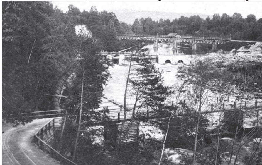
Vykort från Åräsälven i Norra Råda. Landsvägsbron i förgrunden är byggd på timrade stenkistor medan den nya järnvägsbron är av fackverkstyp, byggd i stål. Kortet genom Roy Palm.
