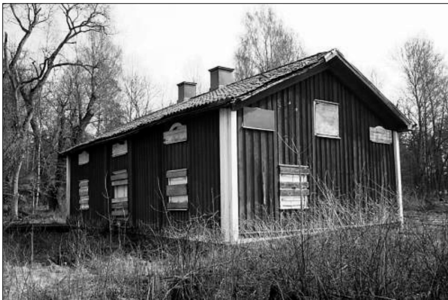
Trangärdstorpens ena flygel. Mangårdsbyggnaden nedbrunnen.
