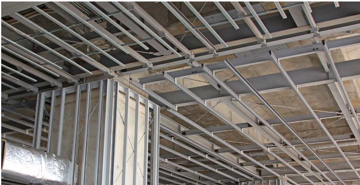
Figur 12 Bild på rambrokonstruktion på station Toyama.
