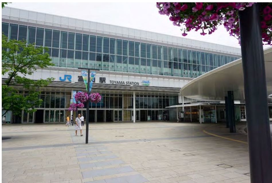
Figur 15 Stationsexempel framsida på västra stationsdelen (Toyama, Japan).
