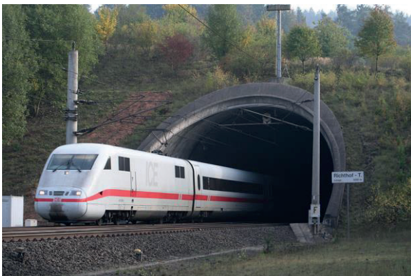
Figur 7 ICE1 vid tunnelmynning, Källa: Wikipedia
