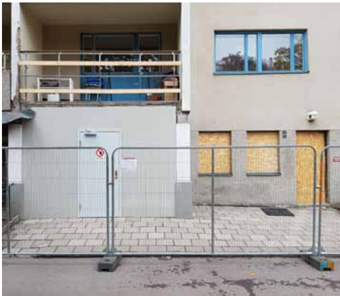
Barnängen provisorisk reparation.
