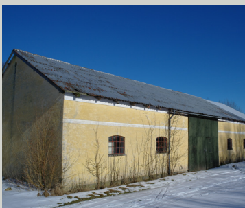
Driftsbygning på Bauehøjgård.
