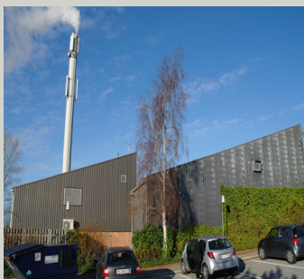
Fjernvarmeværk og hallen set fra Blomstervej.
