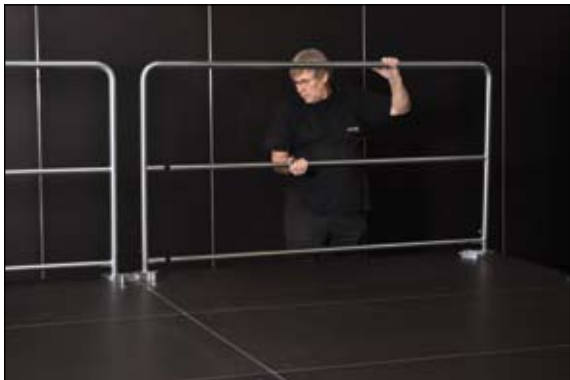
Bühnengeländer hinten aufstecken Sicherungsschrauben festziehen
