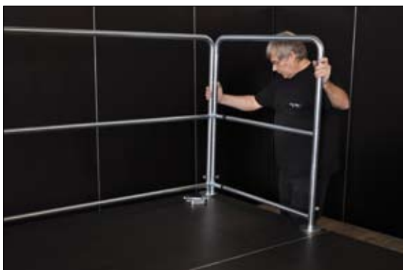
Sæt gelænderet på bagsiden op. Sidegelænderet sættes op med kun 1 bolt, og holdes hen til hjørnet.
