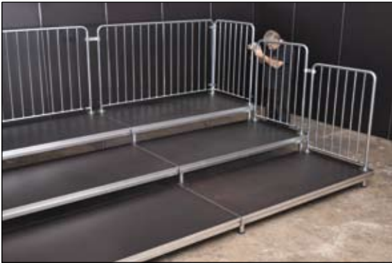
Tribüne aufstellen und Geländer anbringen
