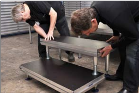
Stufen mit Füßen bestücken, Treppe aufbauen letztes Stufenpodest: Tiefe 39 cm
