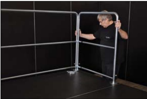
Seitengeländer einsetzen
