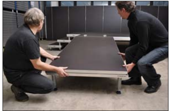
2 Füße einsetzen und Podest einhängen
