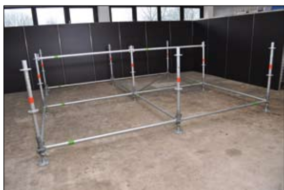
Gerüstkonstruktion nach Plan aufstellen
