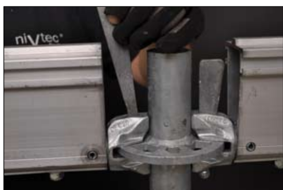
Keilkopf in Lochscheibe einstecken...
