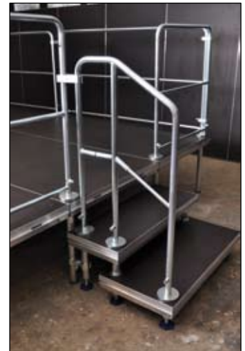
fertige Anstelltreppe inklusive Geländer
