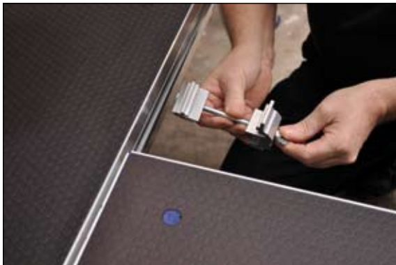
Sicherung mit 2 Podest-Verbindern pro Meter
