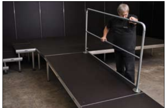
bei Bedarf Geländer einsetzen
