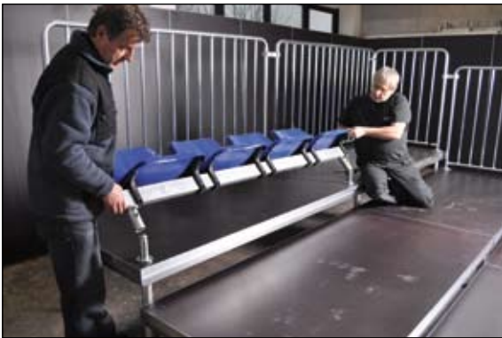
Sitzträger aufstecken und sichern
