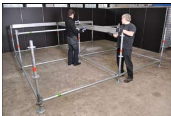
Lastenträger nach Plan einsetzen
