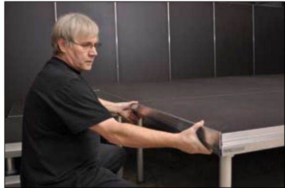
Verblendungsleisten direkt einhängen
