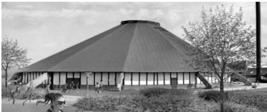
Der satses på renovering af Frederiksværkhallen
