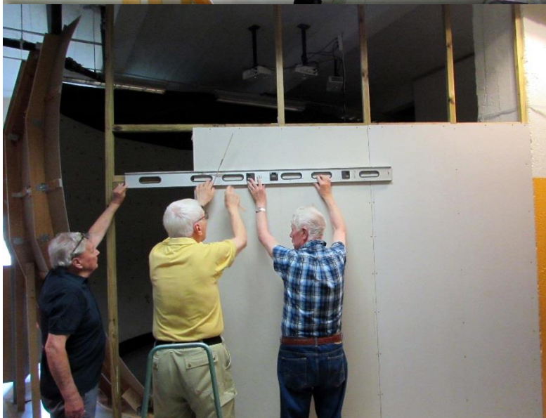
Uppsättning av vägg till simulatorn. Med vattenpass och tre kontrollanter.
