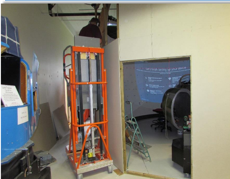
Väggen går mot färdigställande.
