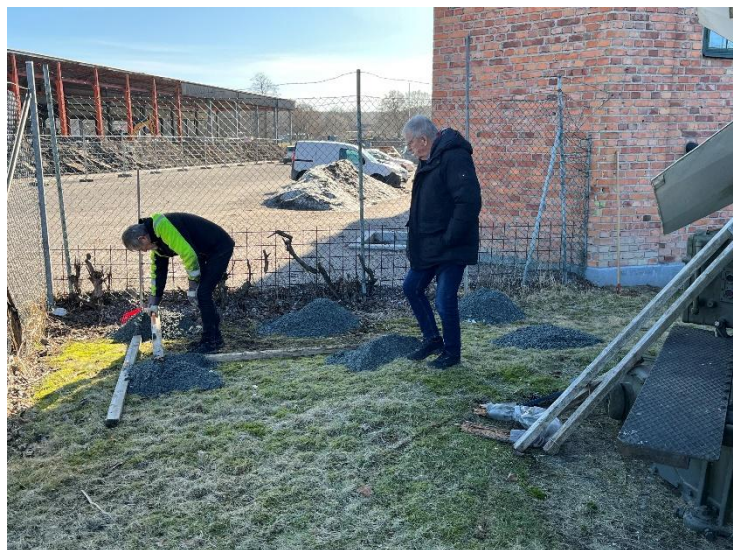
Stefan och Anders Unell har lagt upp grushögar för avvägning av förrådsbodens golvsektion.
