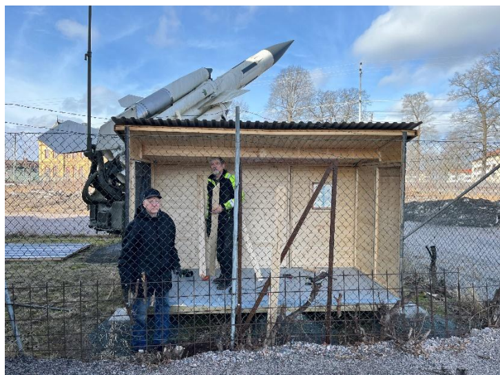
Mats och Stefan förbereder monteringen av södra långväggen.
