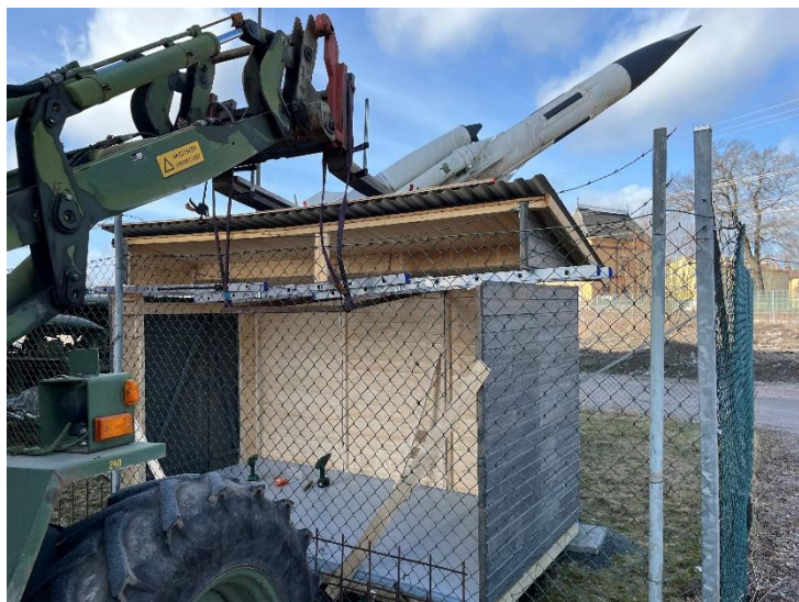
Antero lyfter på taksektionen med sin lastmaskin BM4200.
