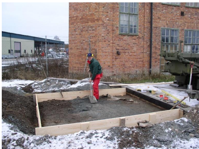
2003 bygger Yngve Löthman och Antero formen till Rb68-fundamentet, här gräver Antero i sandlådan
