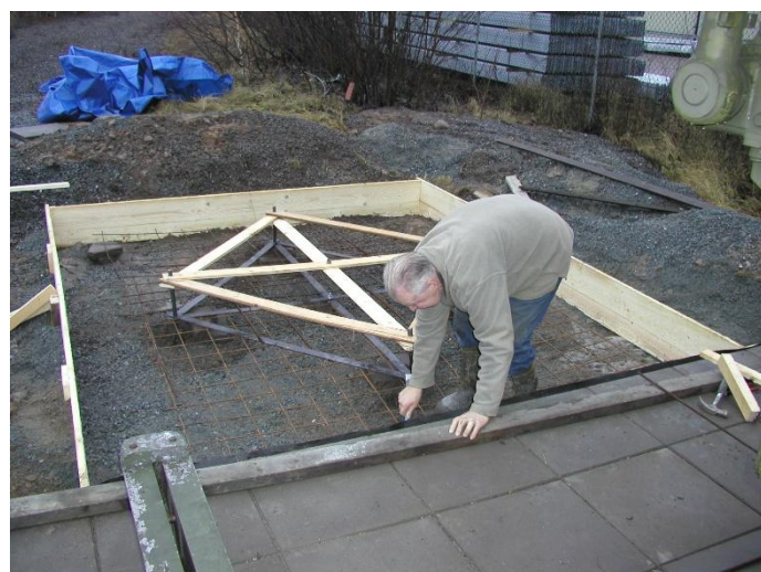
Här har Yngve och Antero armerat och fixerat bultarna till Rb-68 lavetten och Yngve finjusterar inför gjutningen 2003
