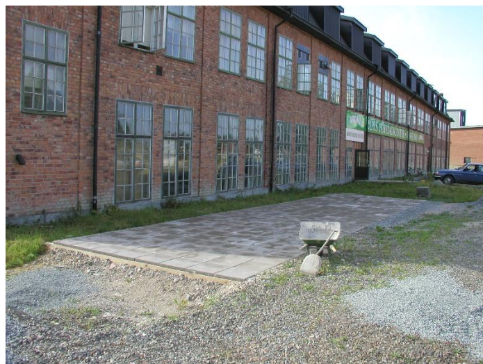
Under dom två första veckorna i augusti 2002 lade Yngve Löthman och Antero Timofejff ut betongplattorna från ingången till Robotmuseet ut till uteplatsen för robotar
