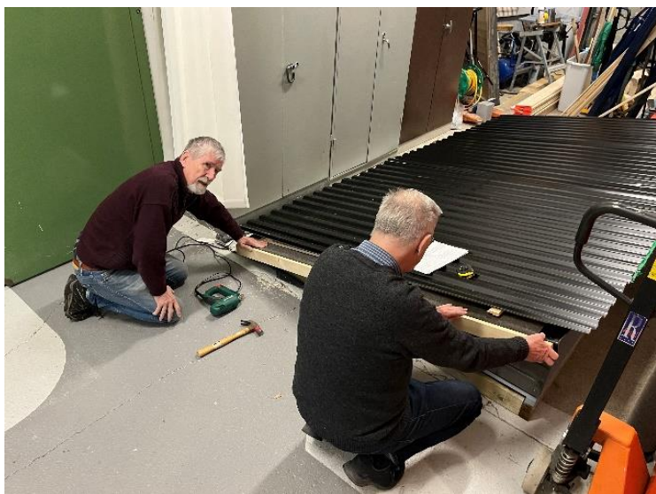
Stefan och Anders Unell skruvar fast den första vindskivan på förrådsbodstaket.
