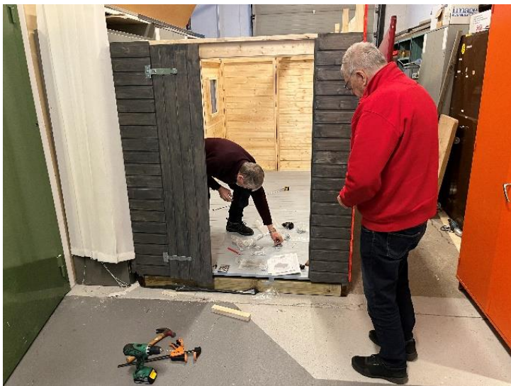
Stefan och Anders U har skruvat fast gångjärnen på den vänstra dörren och det ser bra ut.
