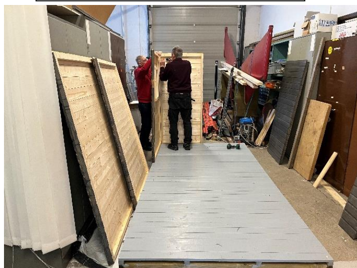
Stefan och Anders U börjar skruva fast väggsektionerna i förrådsbodgolvet.
