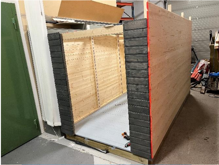
Nu är långväggen klar och klockan är 2100.
