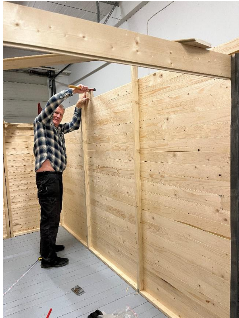
Antero slår fast den sista brädan på långväggen så väggen blir tät och väggen är nu klar. Nästa moment är målning.
