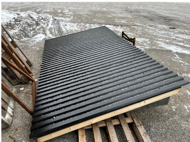
Vi bar ut det plåttäckta taket till förrådsboden.
