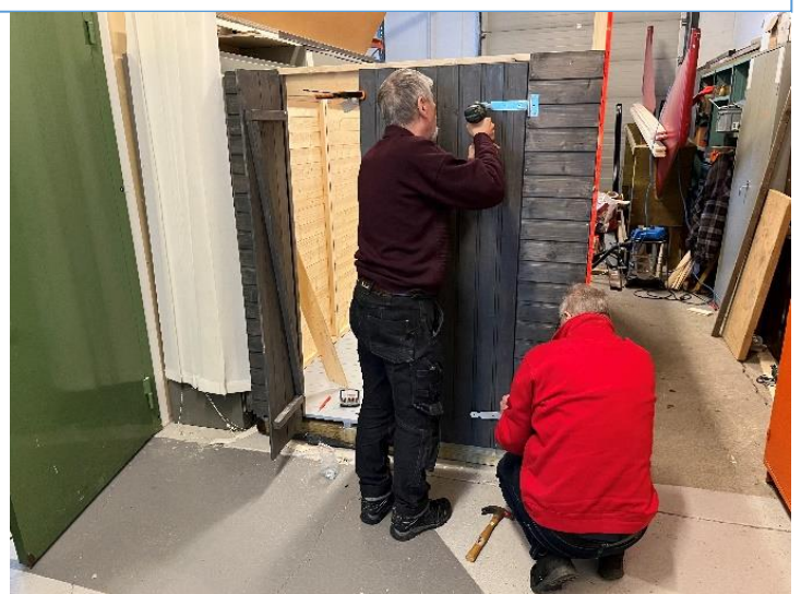
Stefan och Anders U skruvar fast gångjärnen på den högra dörren och det kommer att oxå bli bra.
