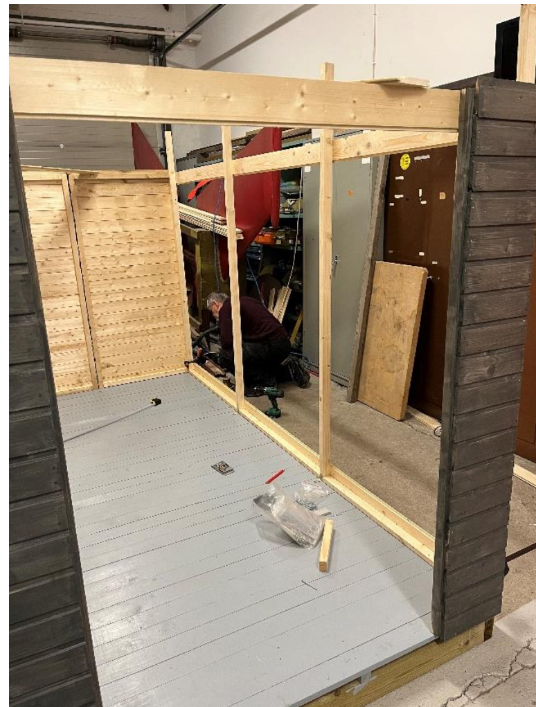
Stefan skruvar fast den första nedersta ytterpanelbrädan på långväggen.
