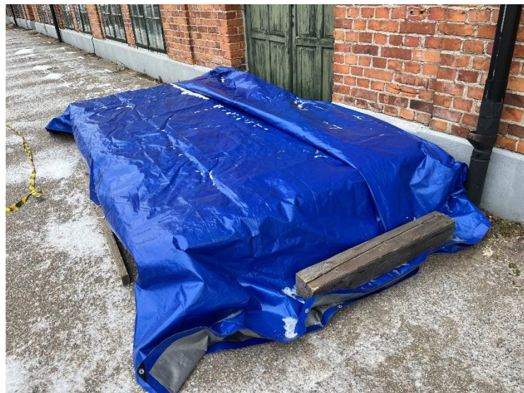
Golv- och vägg-sektionerna är täckta mot väder och vind inför senare flytt.
