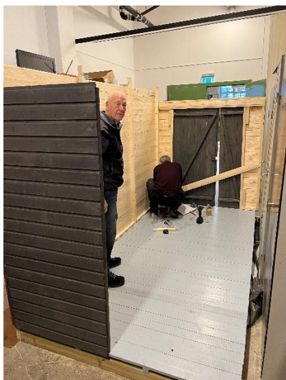
Stefan och Mats har börjat demonteringen av väggarna på förrådsboden.
