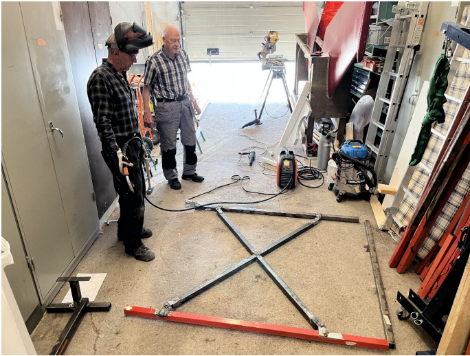
260820 Svetsaren Reidar och Mats klurar ut hur dom ska få alla rörbitar att passa ihop
