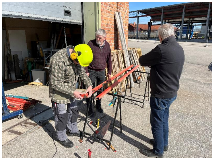
Mats G kapar upp fyrkantsrör till trappställningen där våra störkapslar mm ska placeras på när den ihopsvetsad
