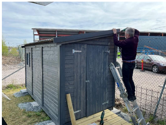
Stefan G skruvar fast vindskivorna och vindskiveplåtarna och förrådsboden är klar utvändigt. Återstår uppsättning av krokar mm invändigt för redskap
