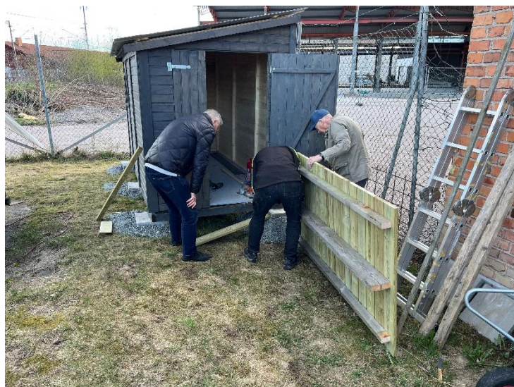
Anders U och Mats G kontrollerar att Stefan G skruvar fast den dubbla bärlinan i mitten på rampen ordentligt
