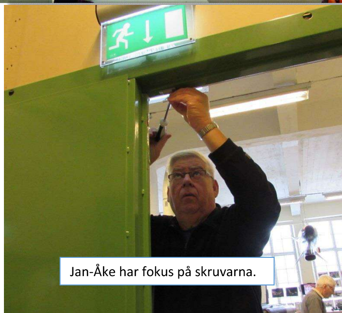
Branddörrar återmonteras.
