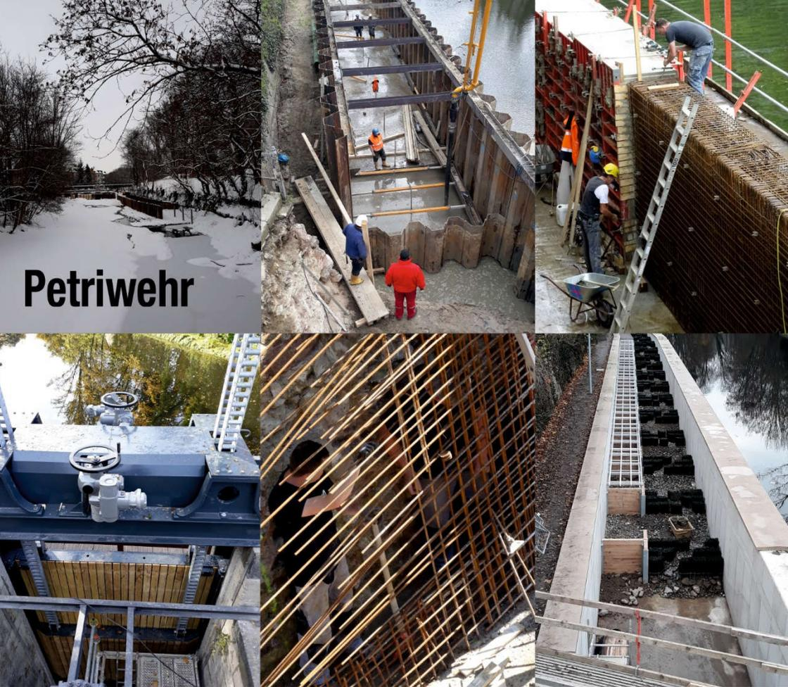
Die Fotos sind von links nach rechts und von oben nach unten: Frostverzögerung, Betonboden zwischen Spundwänden, Spundwände werden mit Bewehrungsstahl und dann mit Beton verkleidet,
