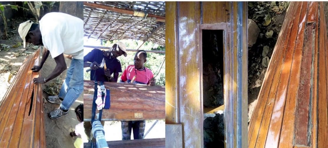
„Ja überlappen in Längsrichtung und in Querrichtung etwas Anschrägen bzw. zur nächsten Planke original-Lannung herstellen - ihr löst das Problem.“
