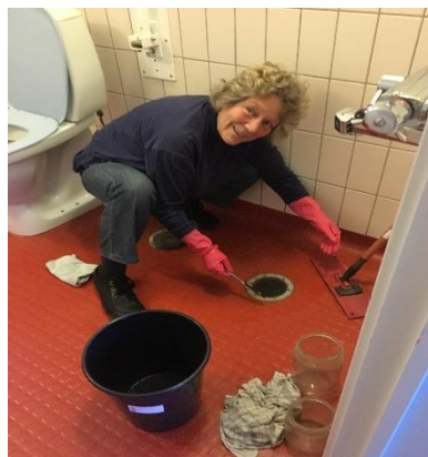
Figur 28 - Stoppede gulvafløb er der en løsning på. Gummihandsker, en skruetrækker og en spand, så er problemet løst.
