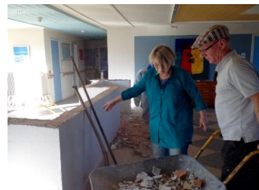
Figur 5- Muren falder, Bodil og Ove i gang
