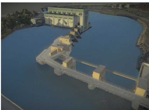
Lilla Edets kraftverk. Kund: Vattenfall Vattenkraft
