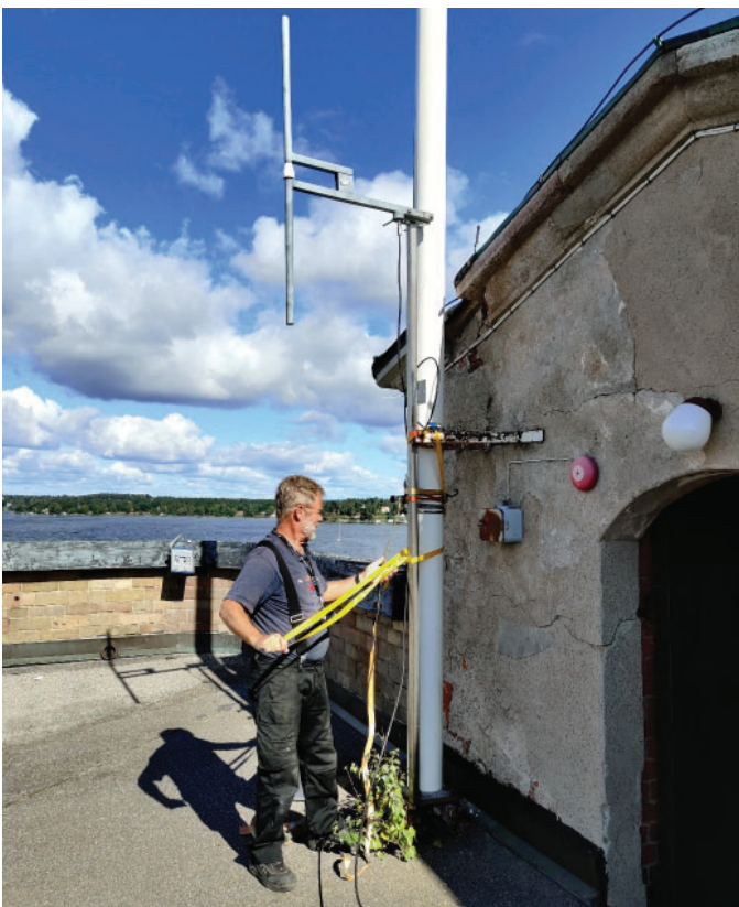
BILD 6: Gunnar SMOOTX drar fast bandet för fastsättning av dipolantennen vid en flaggstång. Nu skulle sändas FM-trafik.
