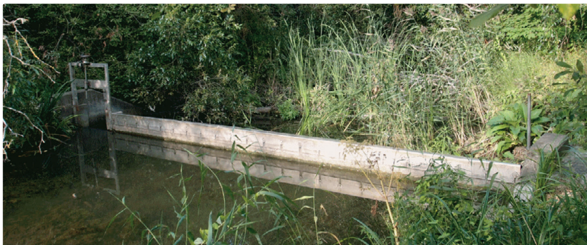
FIGUR 2. Råstadammen har två utskov. Det vänstra utskovet (sett i bild och i strömningsriktningen) består av en skibordslucka och det högra utgörs av en överströmningsdel. Norconsult 2017.
