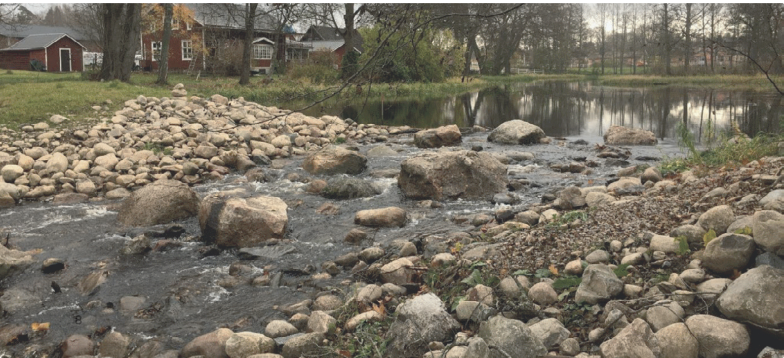
FIGUR 5. Anlagd naturliknande tröskel på plats för tidigare damm i Närke. Norconsult 2016.
