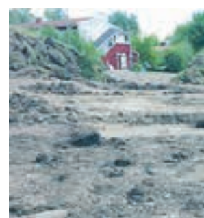
START. Arbetet med att anlägga parkeringsplatser i nationalstadsparken har påbörjats. FOTO: TOBIAS ÖSTBERG
