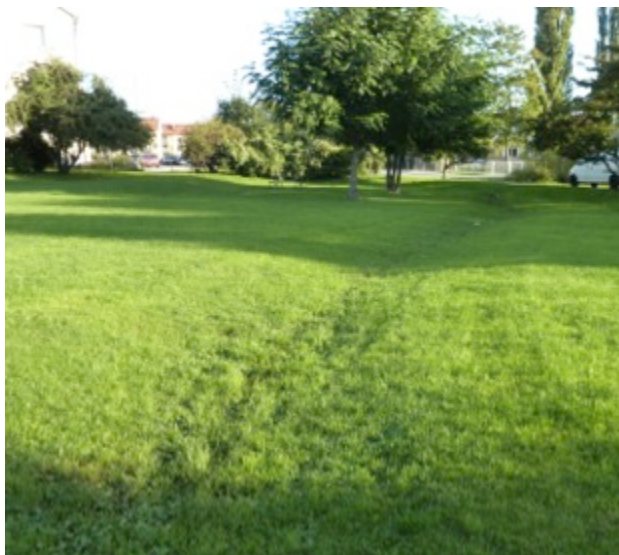
Gräsklätt svackdike. Fungerar som fördröjningsmagasin och översvämningsyta vid kraftig nederbörd (Vectura 2013).
