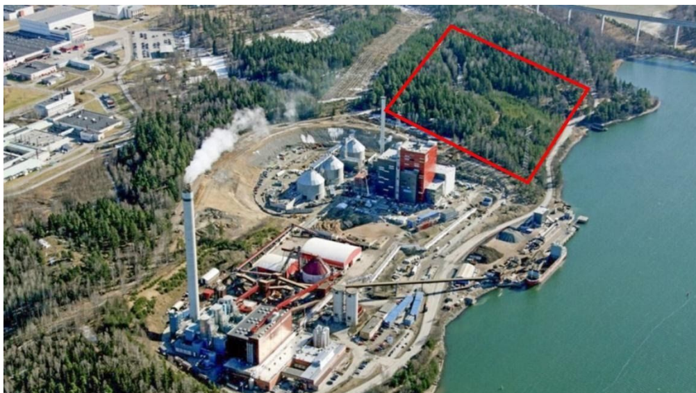
Igelstaverket, foto: Söderenergi
