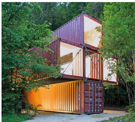
Espace René Greisch sur le site de Montauban-Buzenol © photo: J.-P. Ruelle
