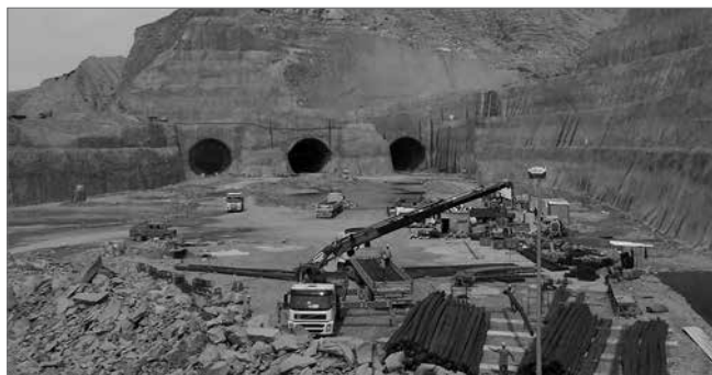
Bauarbeiten am Ilisu-Staudamm gehen weiter
