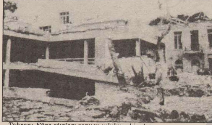
Tahran: Füze atışları sonucu yıkılmış binalar
