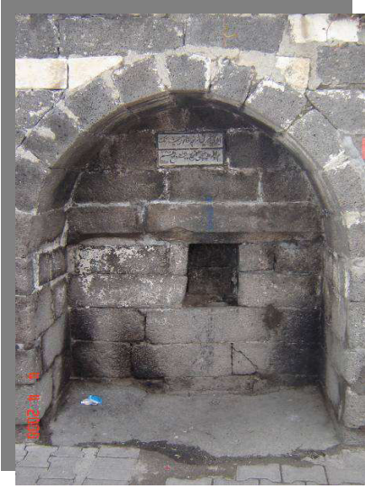
Fot. 1- Tahtalı Katsal Sokak Çeşmesi
