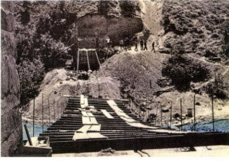
"Devrimci Gençlik Köprüsü" inşaa halinde, 1969
