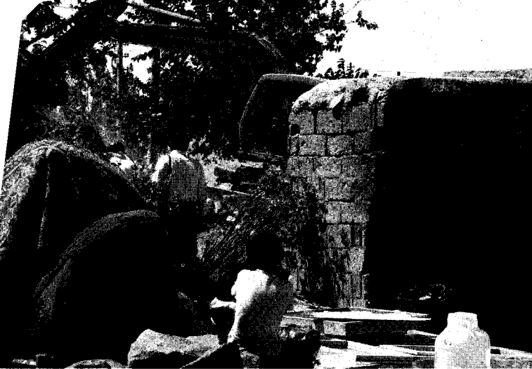
Sloopwerk in Diyarbakir (Foto: M.C.)
