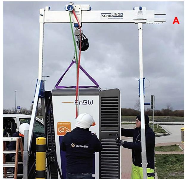
**A: DETALLE DE VIGA SECCIONABLE . Facilita el transporte en furgonetas**
